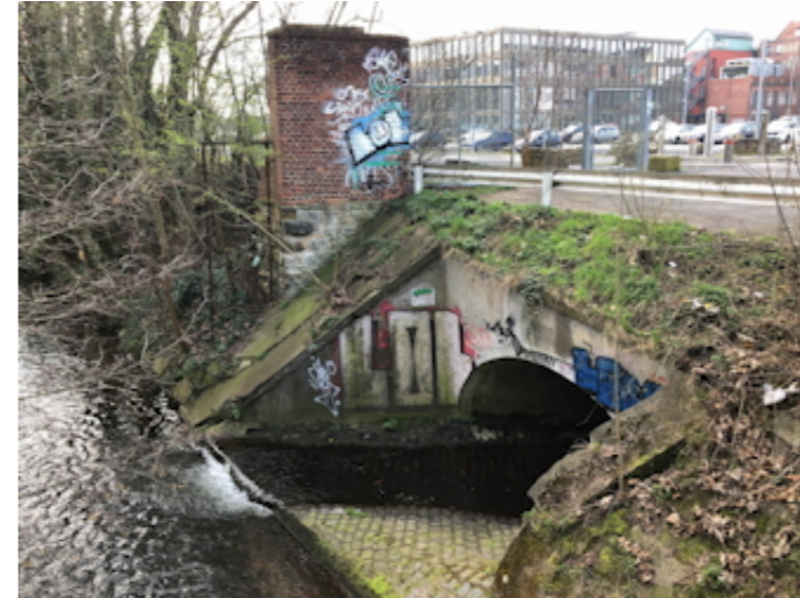
Mündungsportal des seit dem ersten Jahrzehnt des 20. Jahrhunderts verrohrten Mombachs (fotografiert am 17. März 2020 – ©Karlheinz Fingerle)
