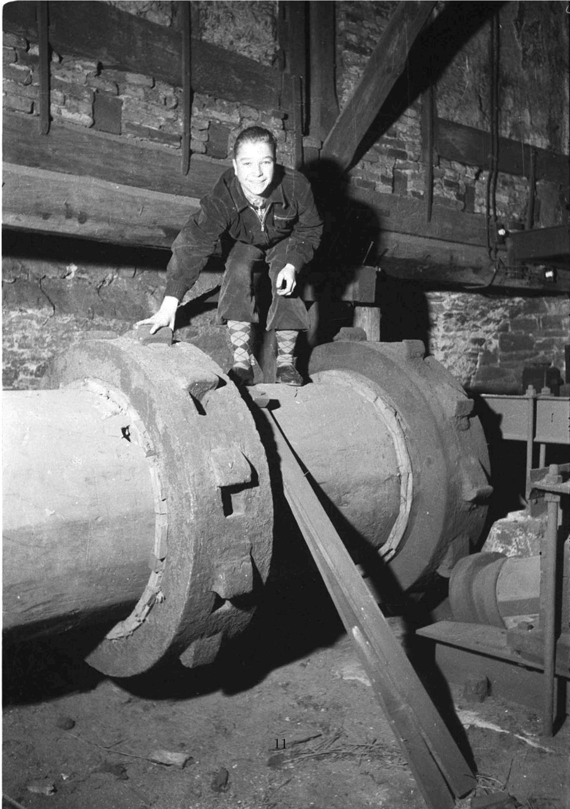
Abbildung 5: „Die elf Meter lange und fünf Tonnen schwere Wasserradwelle“. – Aus: HNA 1.11.1969, Seite [53]8., Fotograf: Werner Lengemann. Wiedergabe der Fotos unter Verwendung des originalen Kleinbildnegativs aus dem Archiv der HNA mit freundlicher Erlaubnis von Frau Sabine Lengemann-Cimiotti.
