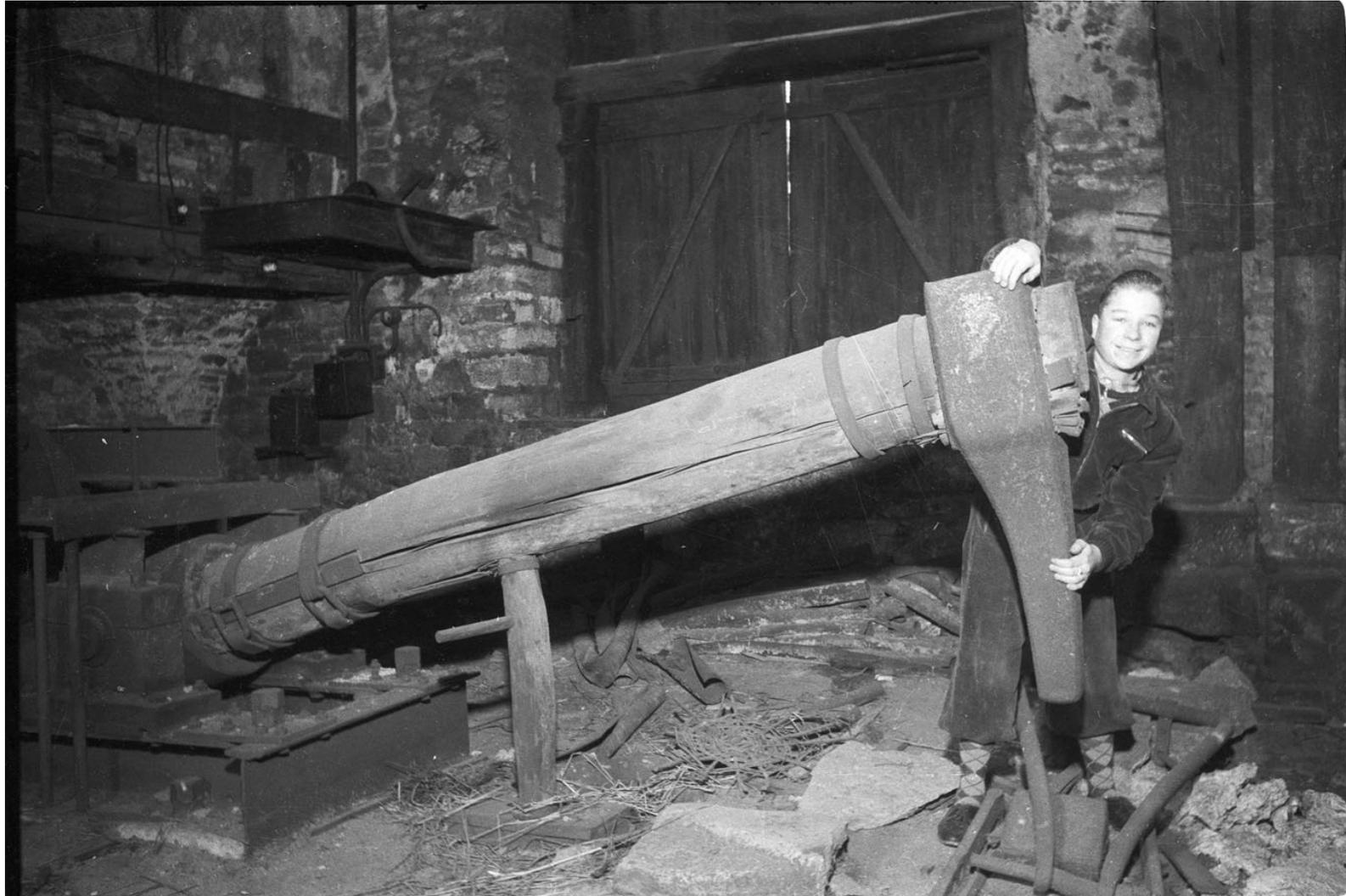
Abbildung 4: „Die mächtige Radwelle aus einem Eichenstamm von 1 m Durchmesser mit zwei starken eisernen Nockenkränzen, die die Hämmer bewegten.“ – Aus: HNA 10.12.1955, Seite 8. Fotograf: Werner Lengemann. Wiedergabe der Fotos unter Verwendung des originalen Kleinbildnegativs aus dem Archiv der HNA mit freundlicher Erlaubnis von Frau Sabine Lengemann-Cimiotti.
