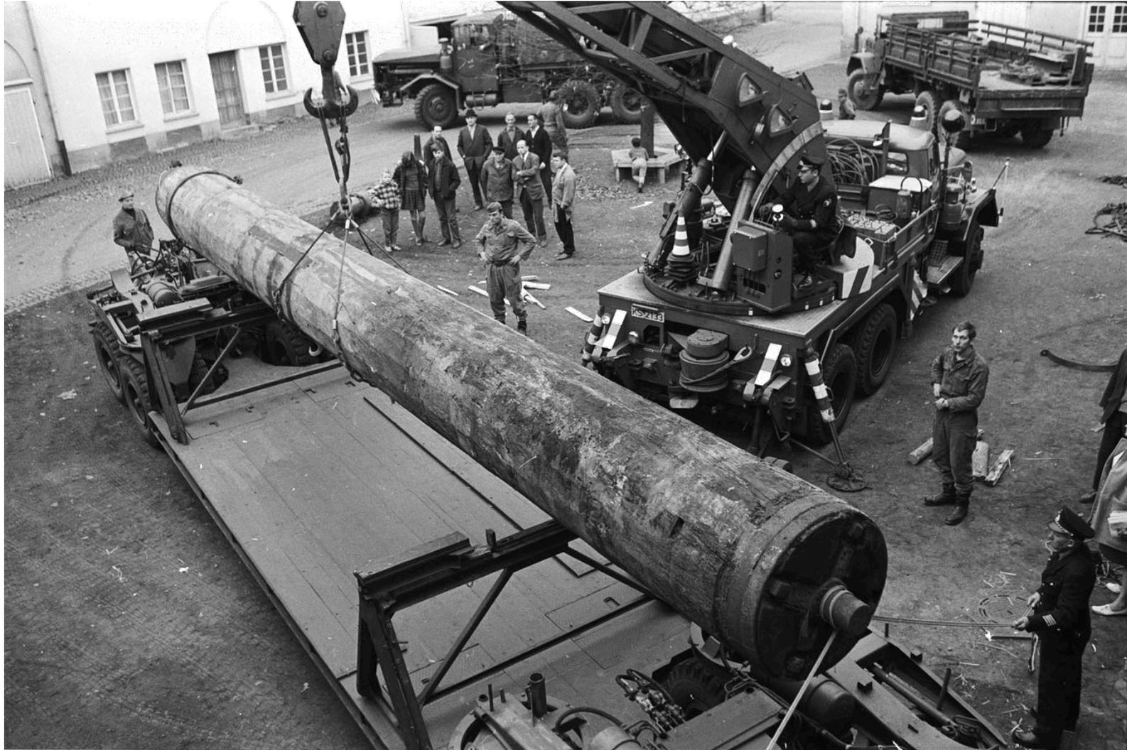
Abbildung 6: Der 1,2 Tonnen schwere Nockenkranz aus Eisen. – Aus: HNA 1.11.1969, Seite [53]8., Fotograf: Werner Lenge-
